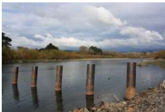
Slika 1. Tipičan usamljeni protočni naper od cevastih šipova [10].
