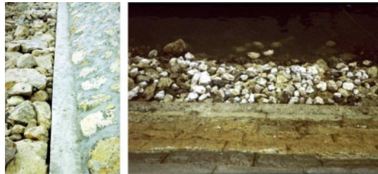
Slika 3.26: Primeri upornih greda; levo: Dunav – Grocka; desno: Sava – Beograd.
