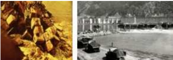
Slika 4.39: Pregrađivanje Dunava u toku izgradnje HEPS Đerdap I; radovi su sa srpske strane obavljani ubacivanjem betonskih kocki, a sa rumunske strane, nasipanjem kamena sa privremenog mosta [35].
