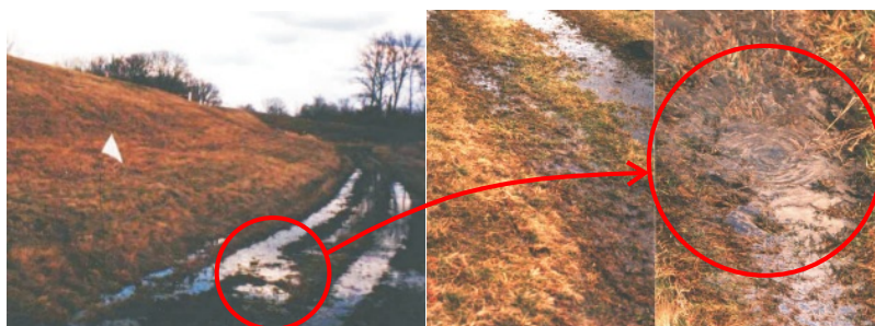
Slika 3.129: Izvor u podnožju nasipa na Tamišu (feb. 1999); bela zastavica označava položaj izvora koji se prati u toku poplave.
