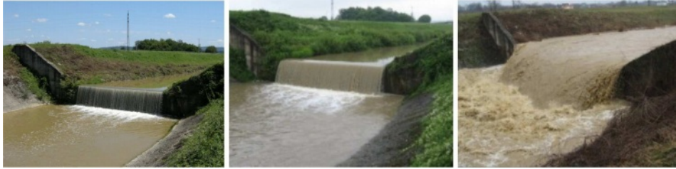
Slika 3.98: Betonski prag na reci Peštan pri maloju, srednjoj i velikoj vodi [65].
