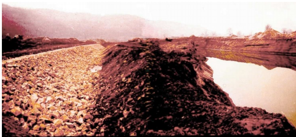
Slika 4.22: Prosek na Velikoj Moravi kod Bagrdana (km 118): iskop sa obaloutvrdom unapred izrađenom u suvom (levo) i kineta pre otvaranja preseka, ispunjena podzemnom vodom (desno).
