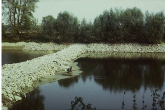
Slika 3.85: Pregrada na Dunavskom rukavcu kod Mohova; izgrađena je od sлагanog kamena, bez glinenog jezgra, tako da je telo pregrade vodopropusno.
