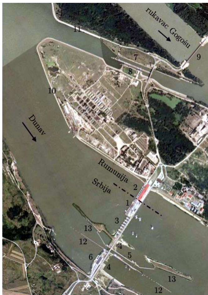
Slika 7.10: Brana „Đerdap II” sa pratećim objektima: 1 – srpska hidroelektrana; 2 – rumunska hidroelektrana; 3 – srpska prelivna brana (rumunska prelivna brana nalazi se na uzvodnom kraju rukavca Gogošu); 4 – neprelivna nasuta brana; 5 – srpska prevodnica; 6 – dodatna elektrana; 7 i 8 – velika i mala rumunska prevodnica; 9 – most; 10 i 11 – zaštitni nasipi; 12 – usmeravajuće građevine; 13 – prilazni kanali za brodove [187].
