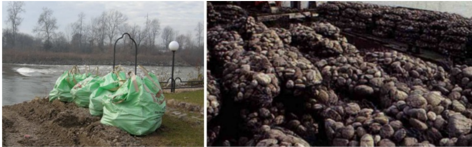
Slika 3.13: Plastične („džambo“) vreće ispunjene kamenom i vrećasti gabioni.
