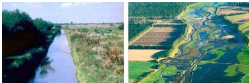
Slika 5.34: Restoracija inundacija reke Brede na jugozapadu Danske (sliv 473 km 2 , dužina oko 1000 km); regulacijom 1950. ispravljeno je i produbljeno korito i isključene su inundacije; posledice su: sniženje nivoa podzemne vode, degradacija tla, smanjenje prinosa, zagađenje vode u reci zbog razgradnje tresetnih naslaga i oksidacije piritita; projektom restoracije (1991-1998) obnovljeno je prirodno povezivanje korita sa inundacijama i rehabilitovana su biljna i životinjska staništa.
