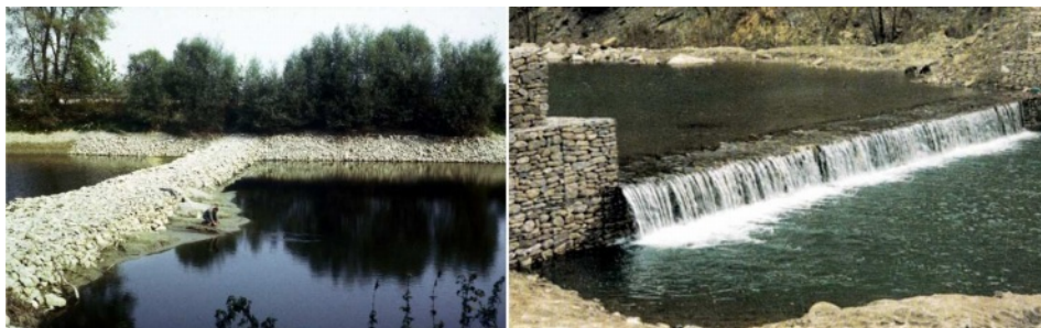
Slika 2.36: Tipični primeri poprečnih građevina; levo: kamena pregrada dunavskog rukavca kod Mohova; desno: kasada od gabiona [1].
