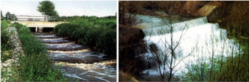
Slika 3.97: Stepenaste kaskade od gabiona [1, 137].
