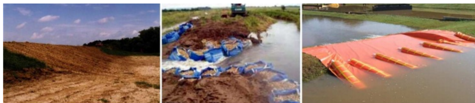
Slika 6.32: Sleva na desno: zatvaranje breše glinovitim materijalom; zaustavljanje širenja breše „džambo” vrećama sa kamenom ispunom [33]; fiksiranje breše folijom i cevastim balastom od poliesterskog materijala presvučenog plastikom [17].
