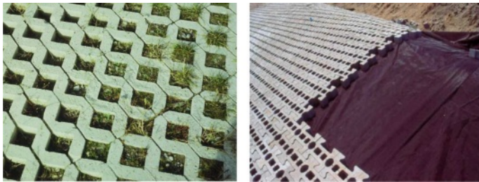
Slika 3.47: Tipovi slobodnih betonskih blokova
