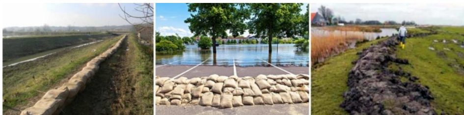
Slika 6.26: Konvencionalno nadvišenje nasipa; sleva na desno: pravilno i proizvoljno naslagane vreće od jute punjene peskom [304] i dodatak od glinovitog materijala [33].
