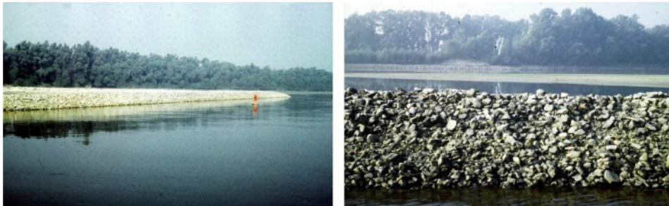
Slika 3.60: Usmeravajuće građevine za potrebe plovidbe na Dunavu; levo: telo PPG na sektoru Siga-Kazuk (km 1420); desno: ulegnuće krune i oštećenje usmeravajuće građevine kod Bezdana (km 1430) nastalo je prelivanjem građevine u periodu velikih voda.
