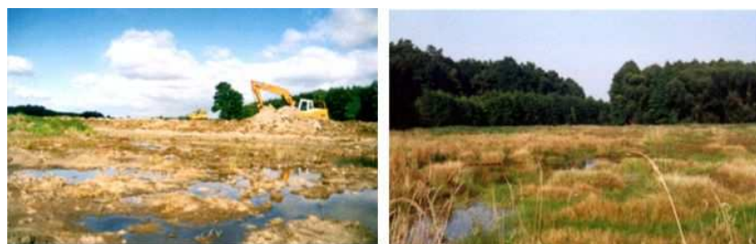
Slika 5.36: Projekat uređenja inundacija reke Lacha u Poljskoj (1999-2002) imao je za cilj povećanje retenzionog kapaciteta za velike vode za oko (150000 m 3 ) i obnovu prirodnih habitata; mere su obuhvatile eksproprijaciju zemljišta, izgradnju niza malih retenzionih bazena, uklanjanje tla zasićenog đubrivom, oblikovanje terena, košenje trave na livadama i izgradnju toplane na energiju biomase.
