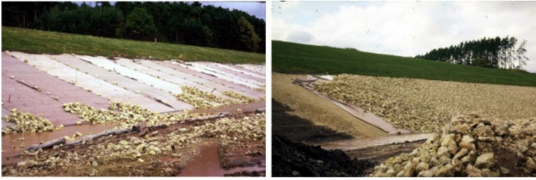
Slika 3.23: Kameni nabačaj na podlozi od geotekstila (kanal „Evropa” na plovnom putu Rajna–Majna–Dunav).
