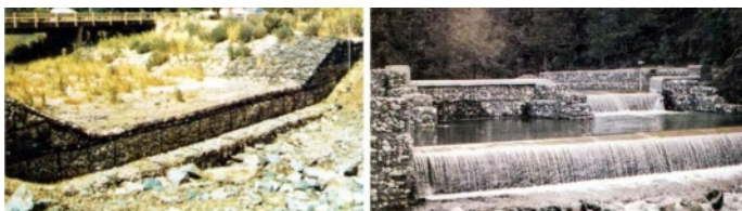
Slika 3.100: Primeri niskih bujičnih pregrada od gabiona koje imaju funkciju stabilizacionih pragova [1, 137].
