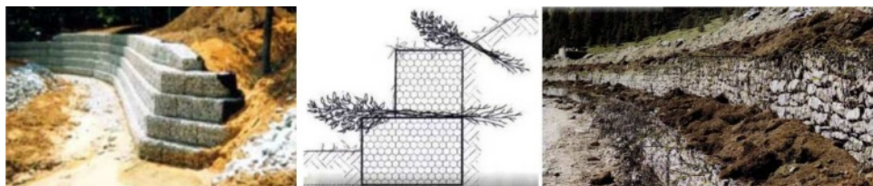
Slika 3.41: Kutijasti gabioni kao obaloutvrde; dodatak sadnica pomaže da se objekat uklopi u ambijent [137].
