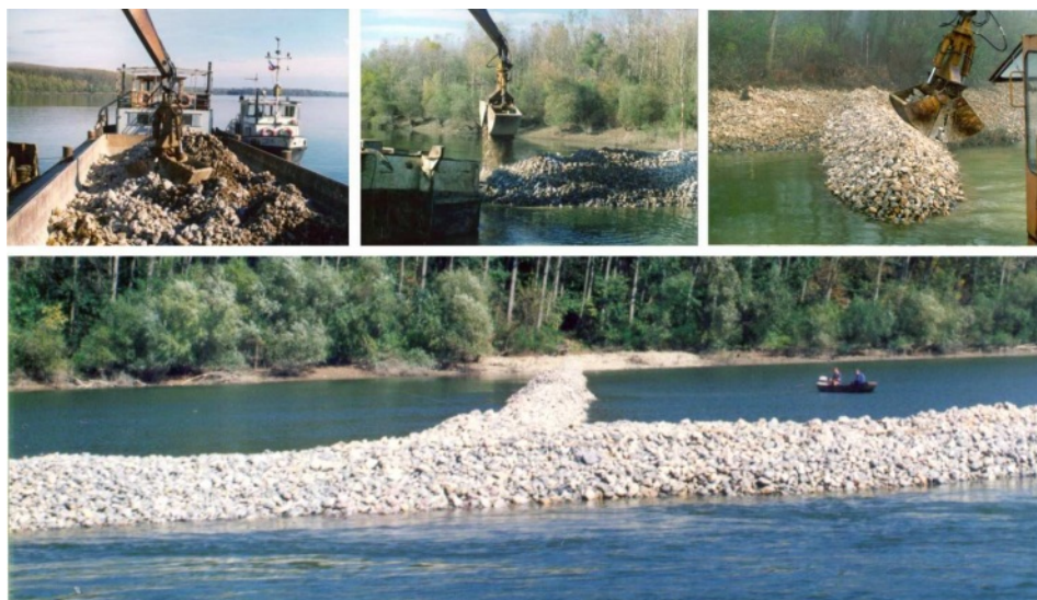
Slika 4.6: Izgradnja napera na Savi – sektor Mrđanovac, km 92+280 [192].
