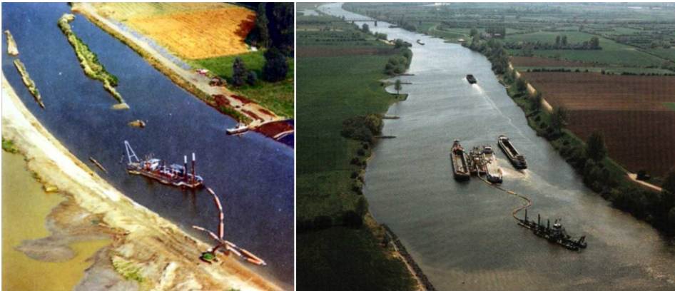
Slika 4.70: Transport i odlaganje izbagerovanog materijala; levo: nasipanje depozite na obali; desno: hidraulički transport materijala do plovila za odvoženje izbagerovanog materijala.
