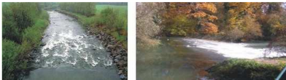
Slika 5.19: Primeri regulisanja uzdužnog nagiba rečnog korita pomoću rampi; levo: pogled nizvodno na rampu u koritu reke Murr (pritoke reke Neckar) u Nemačkoj [79]; desno: betonska rampa na reci Karaš.
