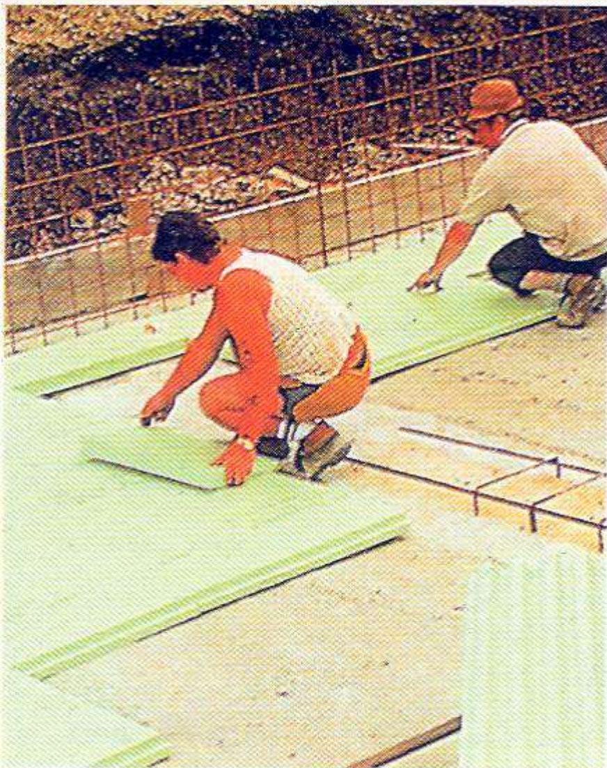
Toplotna izolacija ispod podne ploče
