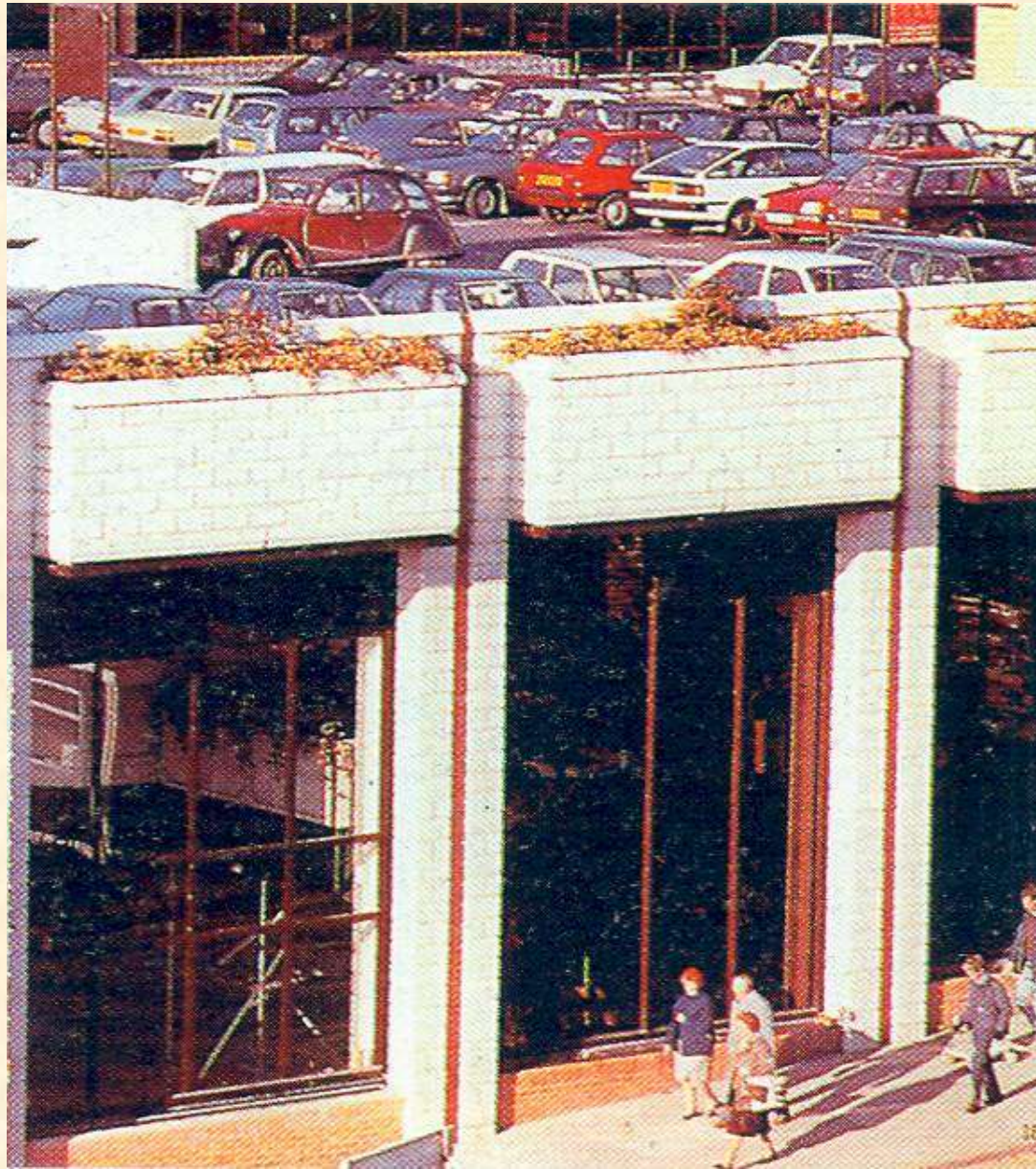
Toplotno izolovana parking terasa iznad jednog tržnog centra
