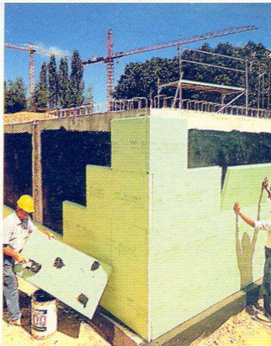
Toplotna izolacija spoljnjeg podrumskog zida
