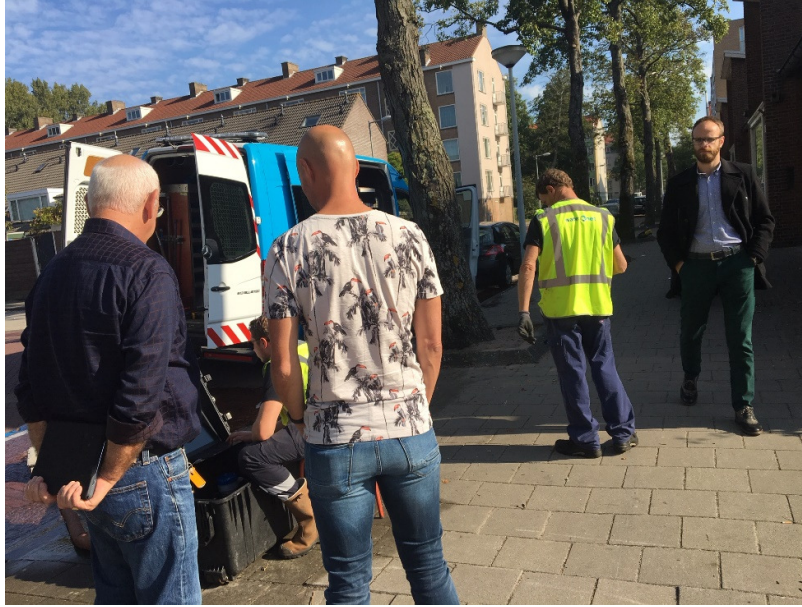
Слика 2. Излазак на терен – испирање водоводне мреже
