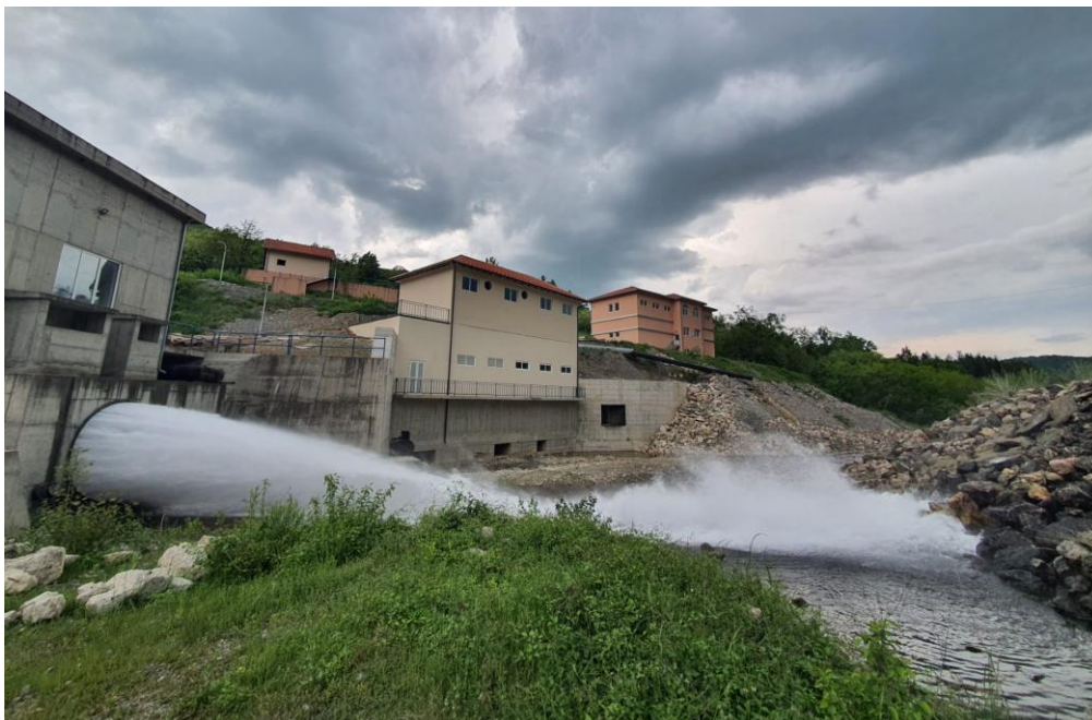
Temeljni ispust pri otvorenosti zatvarača od 5% (2023)
