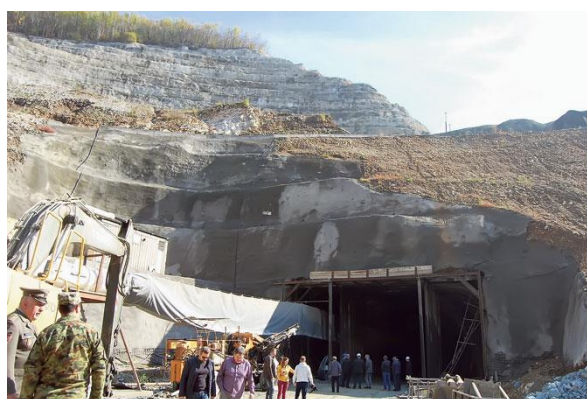
Ulazni portal potočnog tunela
