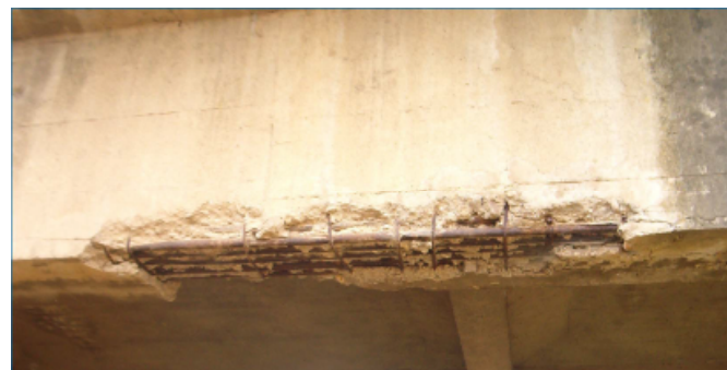
Korozija armature i otpadanje zaštitnog sloja betona (karbonatizacija, hloridi)
