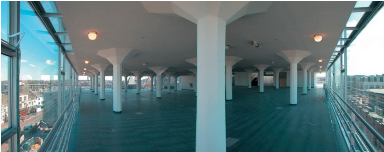
AB međuspratna konstrukcija u poslovnoj zgradi
