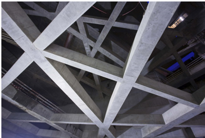
AB međuspratna konstrukcija u poslovnoj zgradi
